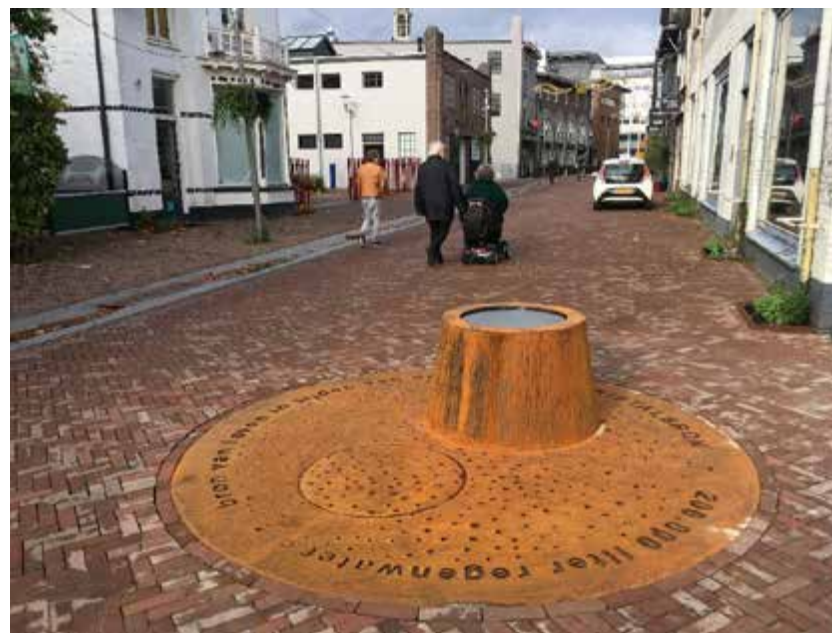
Cisterne 'Kristalbron' aan de Marktstraat, voor opslag van 200.000 liter regenwater om bij droogte water te geven aan het groen in de binnenstad (foto Hendriek Rossingh)
