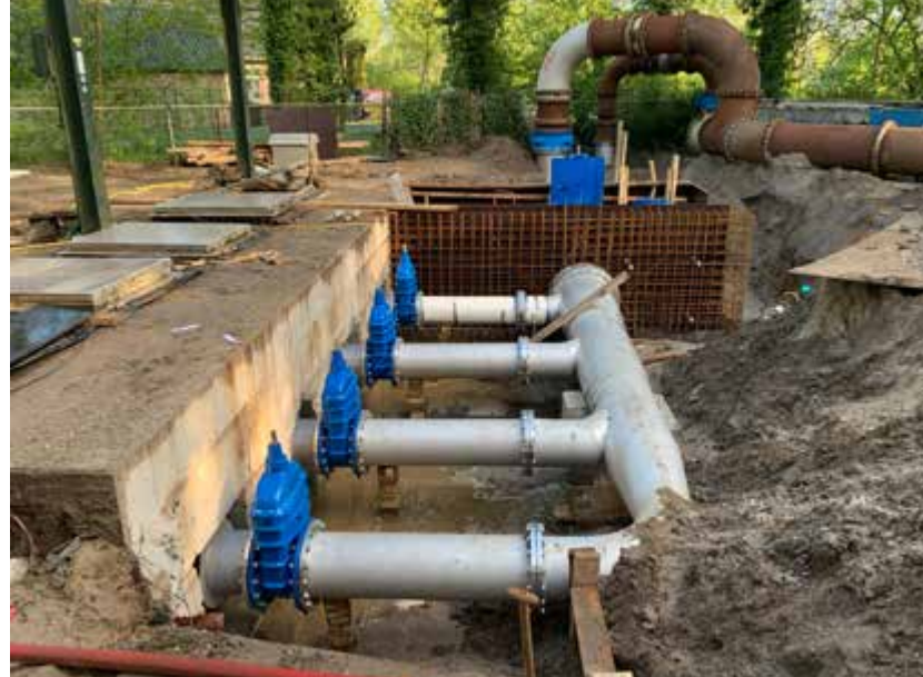
Renovatie gemaal Anklaar, het grootste gemaal voor afvoer naar de rioolwaterzuivering
