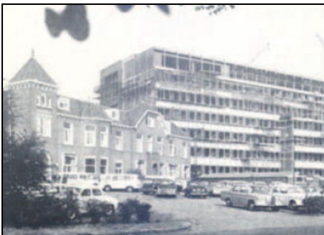
Nieuwbouw Julianaziekenhuis in 1963. Nog in aanbouw.
