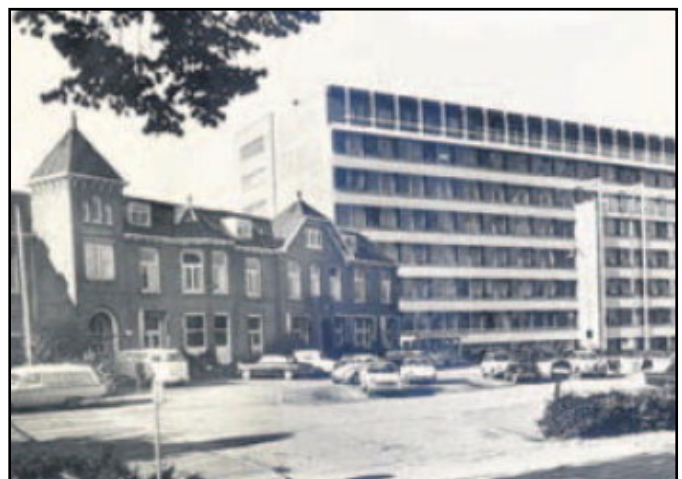
De nieuwbouw van het Julianaziekenhuis. Gereed in 1968.
